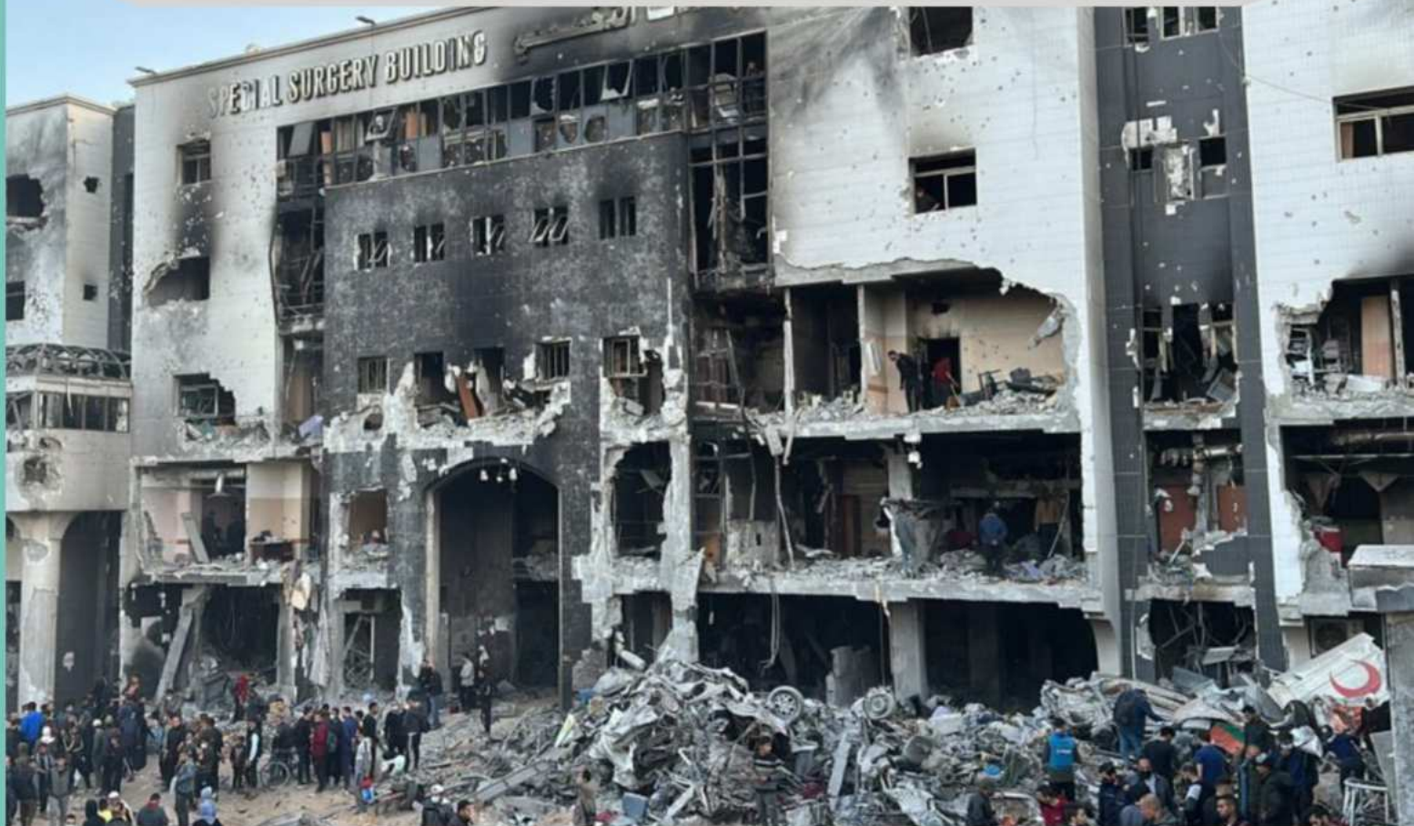
Zdjęcie przedstawiające zniszczony szpital Al Shifa w Strefie Gazy, kwiecień 2024
